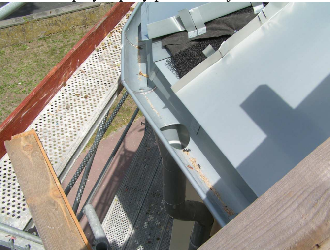
Szczegóły montażu blach na powierzchni kopuły
