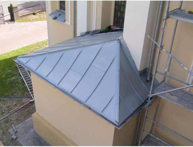
Skarbczyk po renowacji ścian i wymianie blach na dachu
