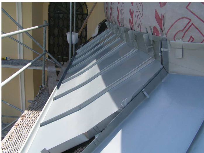
Wymiana blach na okapie kopuły kaplicy
