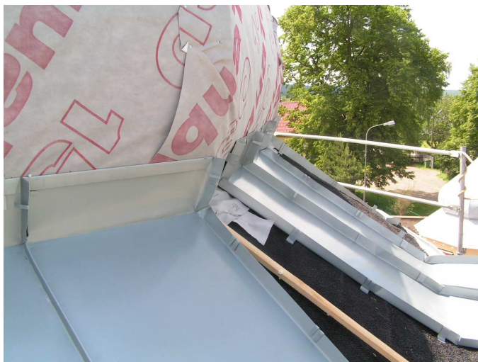
Układ blach na kopule kaplicy
