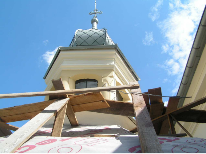
Latarnia kopuły kaplicy po renowacji
